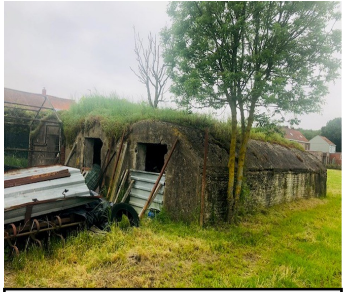
British bunkers at Hyde Park Corner, Ploegsteert.
